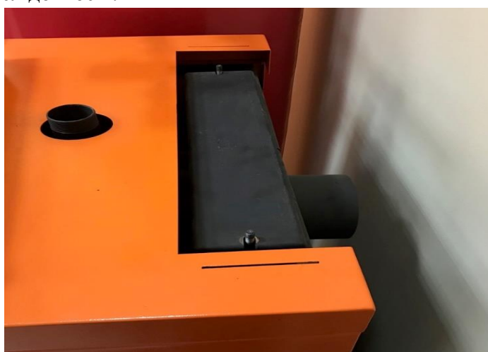
зняти задній люк верхньої обшивки котла
