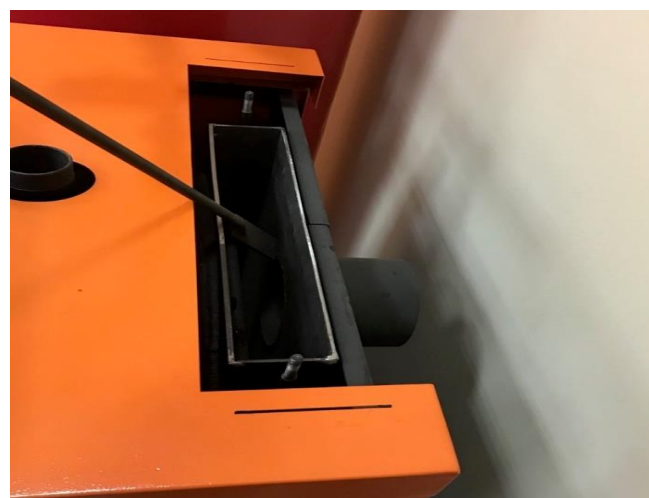
за допомогою шкребка, очистити теплообмінник
