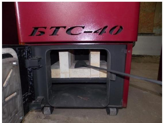
После очистки загрузить топливо на уголь, который остался, и осуществить розжиг котла.
