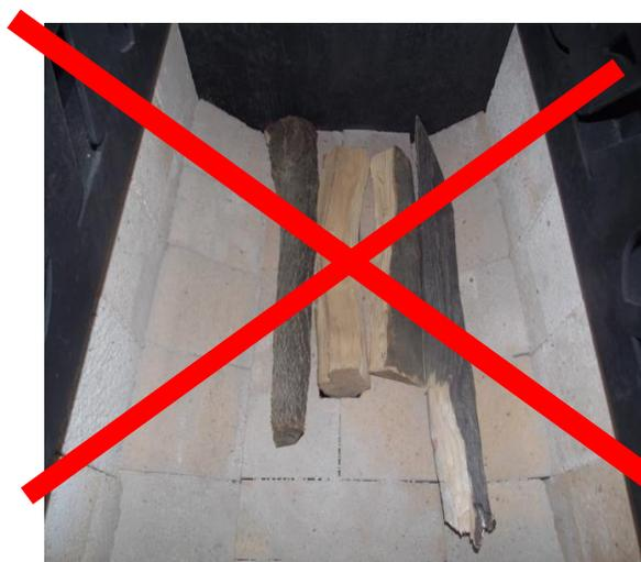
12.2 Используя факел осуществить розжиг, закрыть средние дверцы загрузочной камеры. Когда дрова достаточно разгорятся, догрузить дрова. Регулятором температуры выставить желаемую температуру теплоносителя от 65-85 °С.
